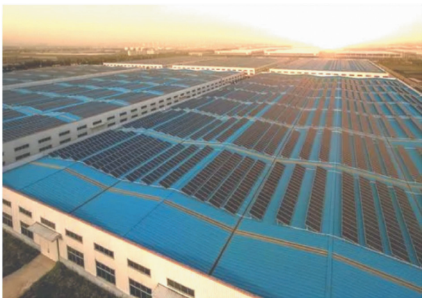
安徽德力日用玻璃有限公司屋顶分布式光伏发电项目
