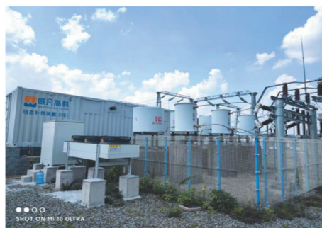
江苏硕赢新能源科技有限公司10KV车间新建项目
