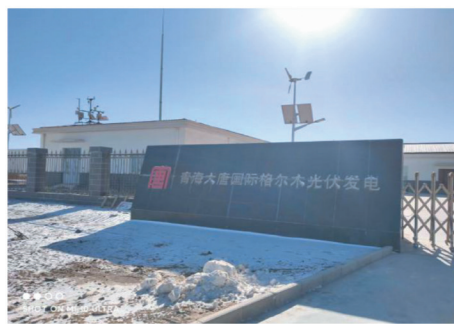
青海大唐国际格尔木光伏发电项目
