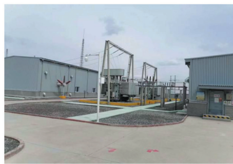
镇江新纳材料35KV 变电所新建项目
