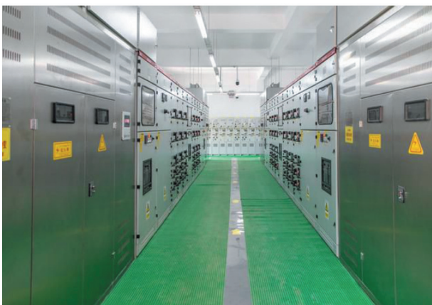
保利泰克电力电缆及配电柜安装项目
